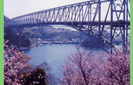
天門橋(天草五橋一号橋)
