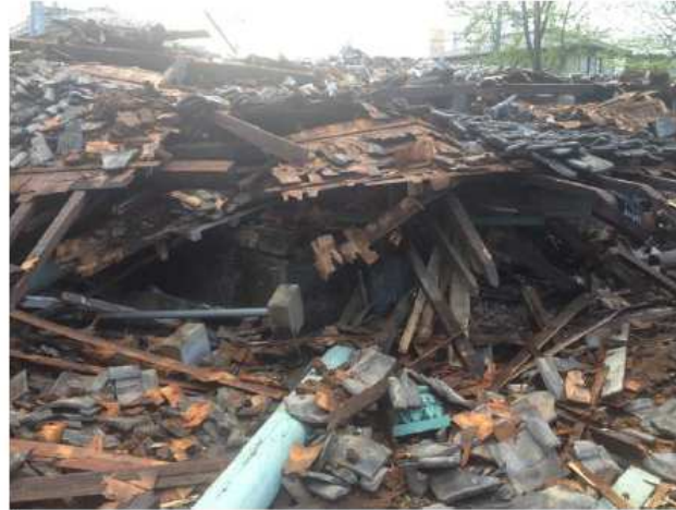
▼ 県 洋学校教師館（倒壊）
