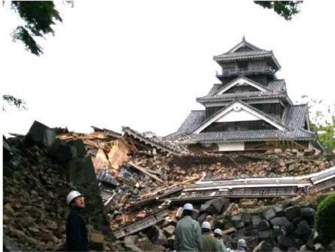
▼ 宇土櫓・続櫓と石垣（倒壊）
